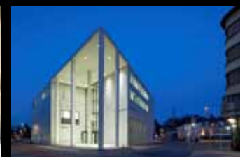
Tribunal de la Paix Architecte: Jim Clemes Atelier d'Architecture et de Design © Ville d'Esch-sur-Alzette
