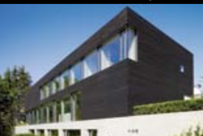
49°37'10.56" N, 6°9'19.41" E extérieur, côté rue ● Photographie : Lukas Roth
