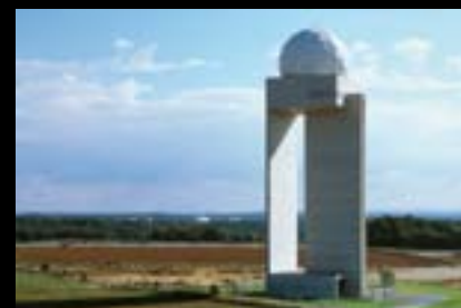
tour visible depuis la rue de Luxembourg, 5230 Sandweiler ● Photographie : Lukas Roth
